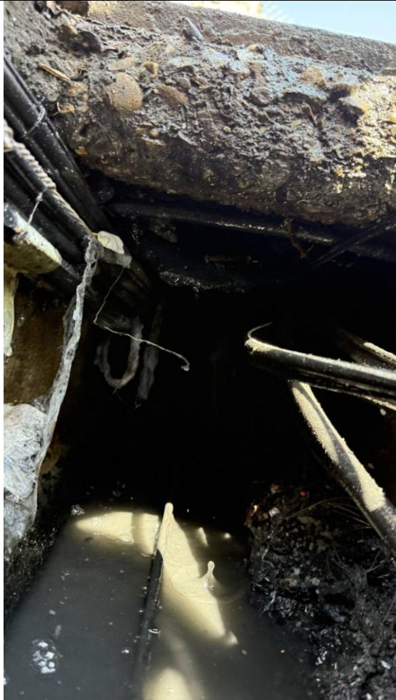
處置作為說明：排水溝疏通維護
