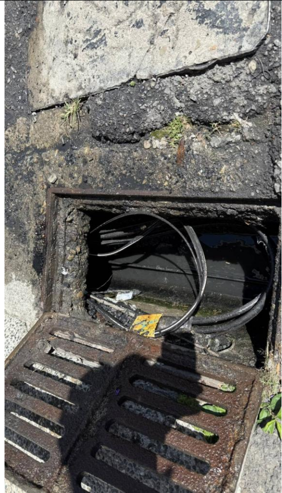
處置作為說明：排水溝疏通維護
